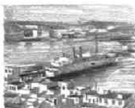
تصویر ۶-۳۰ - ترکیب‌بندی زیگزاگی.
